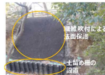
索掘り法面を保護するための工事
