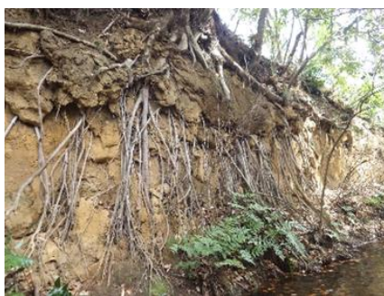
＜根系発達による表層の崩落＞
