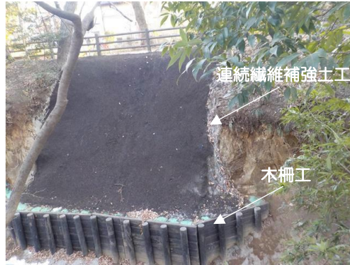
写真-10 法面保護工施行例
