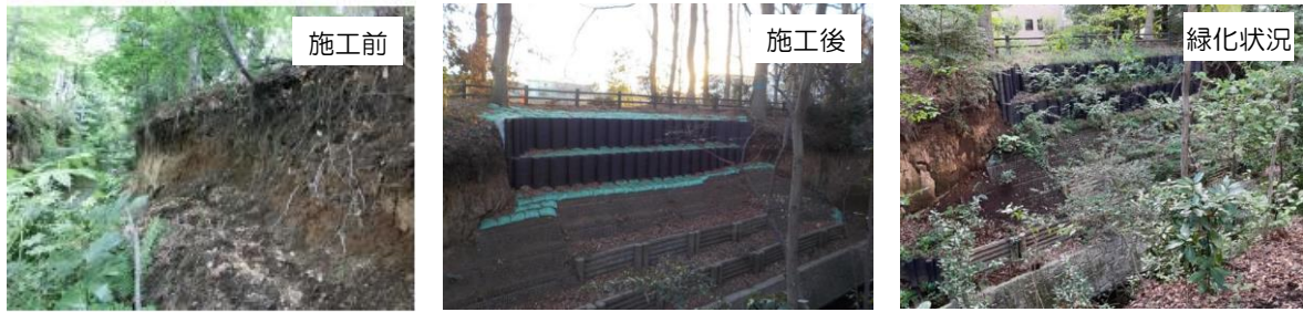
＜木柵工による法面保護工実績：西中島橋下流（右岸）＞
