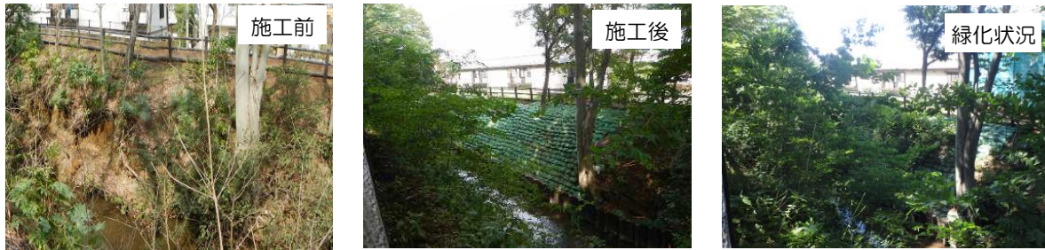
＜連続繊維補強土工による法面保護工実績：井の頭橋上流（左岸）＞
