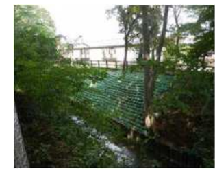
素掘り法面を保護するための工事（前後）
