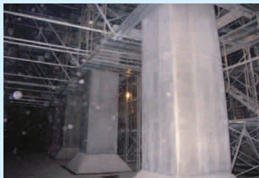
配水池の耐震補強
