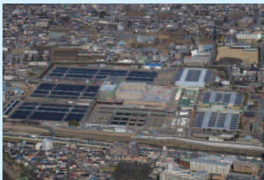
東村山浄水場 [126.5 万 \text{m}^3 / 日]
