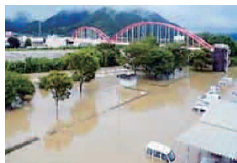
豪雨災害による浄水場の水没
