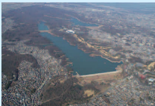
村山下貯水池の堤体強化
