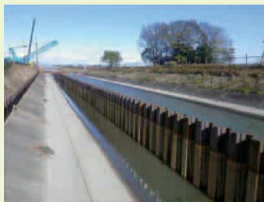
導水量を制限して改築工事を実施
