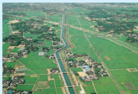
導水路（武蔵水路）
