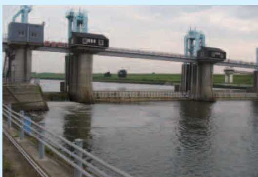
取水堰（秋ヶ瀬取水堰）
