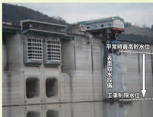
貯水位を下げて更新工事を実施
