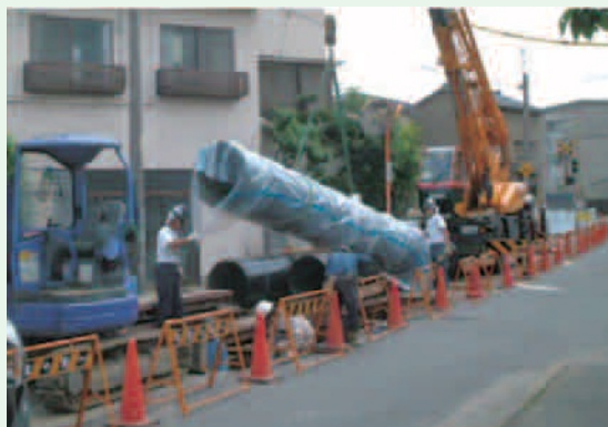
水道管路の取替工事
