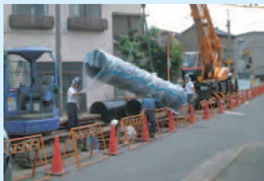
耐震継手管への取替工事
