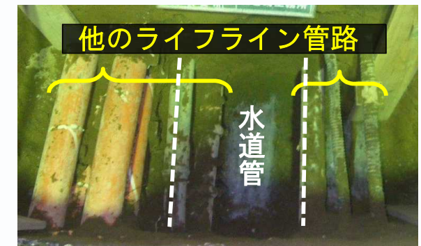
埋設物が輻輳している例
