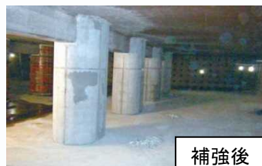
＜浄水施設の耐震化＞ （沈殿池内部の柱補強）
