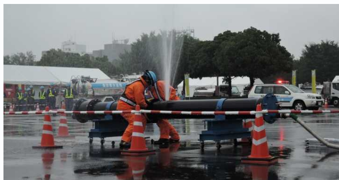
〈漏水を修繕する応急復旧訓練〉
