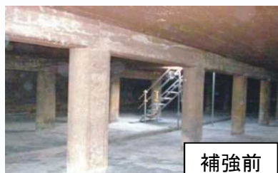
＜浄水施設の耐震化＞ （沈殿池内部の柱補強）
