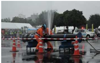
〈応急復旧訓練〉
