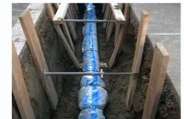
ポリエチレンスリーブを被覆した管路
