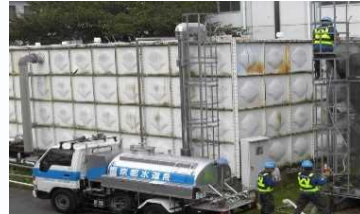
〈給水車による応急給水〉
