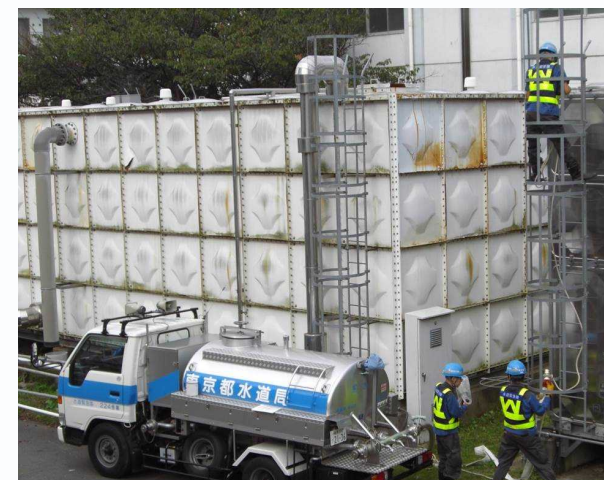
〈給水車から医療機関への応急給水〉
