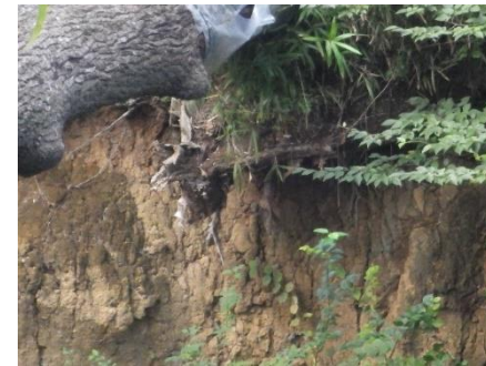
（直壁状法面の状況）
