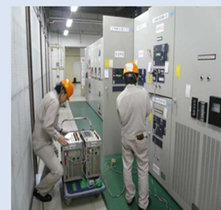
④保護継電器試験
