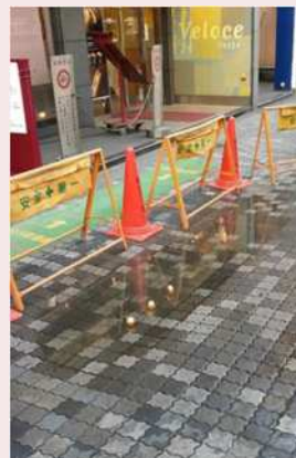
▲給水管漏水 (舗装へ浸出)
