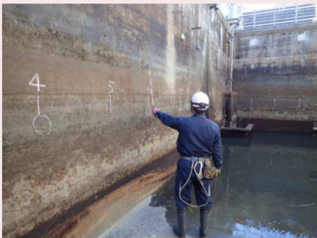
▲コンクリート構造物の目視点検
