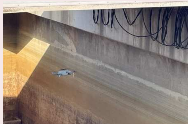
▲ドローンによる画像撮影時の様子 ドローンを操作しながら、構造物壁面全体を撮影しています。 コンクリート構造物の点検に、ドローンを試行的に導入しました。ドローンで撮影した構造物壁面の画像を解析し、ひび割れ等の損傷状況を調査しました。
