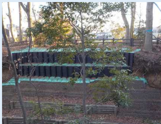
▲法面保護工事の実施 流水や風雨等の影響により崩落や浸食を受けている法面を補強しました（玉川上水）。
