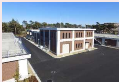
▲ 清瀬梅園給水所 清瀬梅園給水所は、令和3年度に完成しました。
