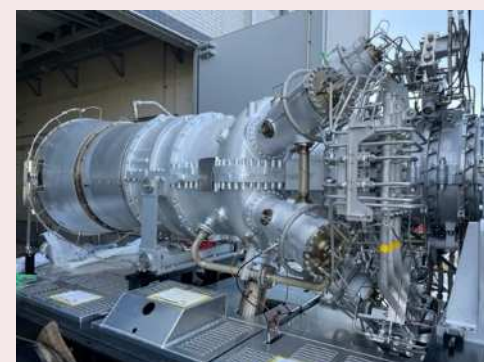
▲三郷浄水場(常用発電設備) 常用発電設備工事等を実施しています。
