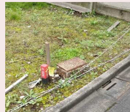
▲使用見込みがないまま放置されている給水管
