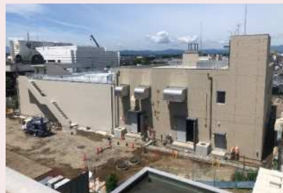
▲ 柴崎給水所 柴崎給水所は、現在、計画どおり拡充工事を行っております。
