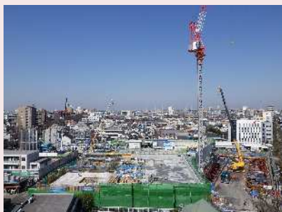
▲ 上北沢給水所(仮称) 配水池頂版築造状況
