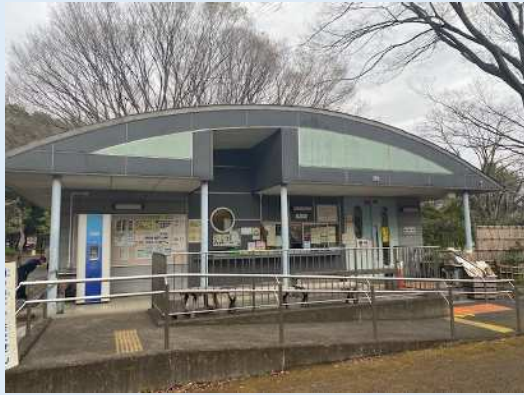
▲都立砧公園に設置したシンボリックな水飲栓
