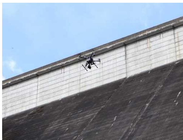
<ドローンによる貯水池堤体の点検>
