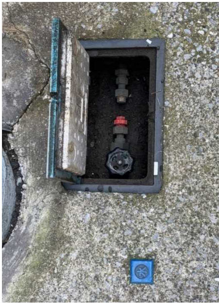
＜長期間水道メーターが 取り外されている給水管＞
