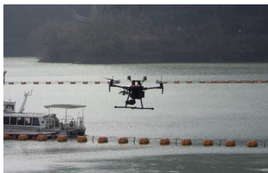
<ドローンを活用した点検>
