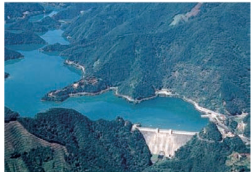
▲ 小河内ダムの全景
