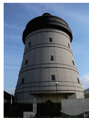
▲ 大谷口給水所（平成23年3月完成）
