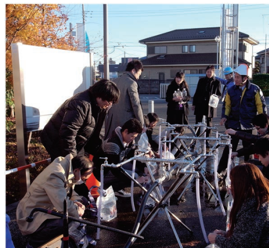
▲ 消火栓への給水栓設置訓練
