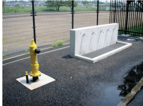
▲ 改造後の応急給水拠点（北野給水所）
