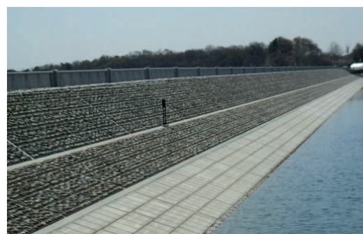
▲ 水道施設の耐震化（村山下貯水池堤体）
