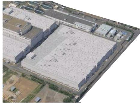
○更新までの間は、日量100万立方メートル以上の施設能力を有する浄水場や導水から送水まで自然流下により運用が可能な浄水場を対象として、開放面積が大きい沈殿池を経済性に優れた「シート型」で覆蓋化し、降灰も含めた異物混入対策を進めます。
