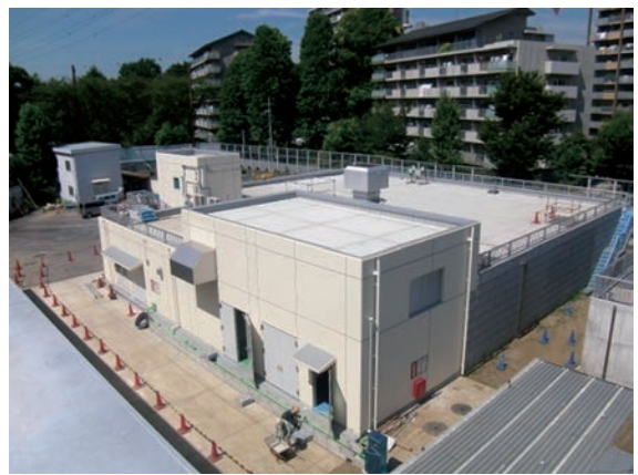
▲ 多摩平浄水所（平成24年度完成予定）
