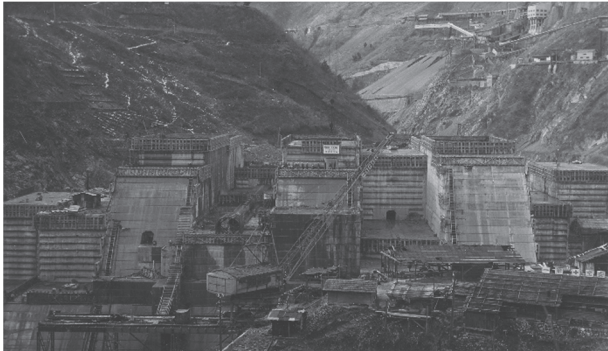
小河内ダムの建設風景
