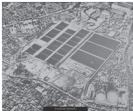
淀橋浄水場（昭和39年頃）
