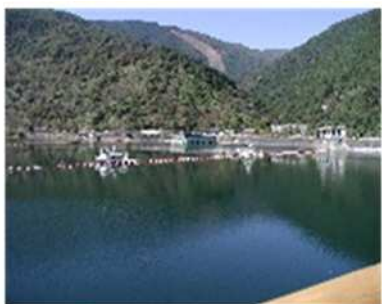
小河内貯水池
