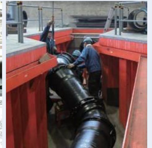
▲水道管をつなぎ合わせる訓練
