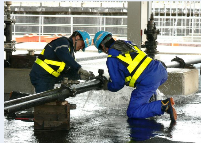
▲漏水した水道管を修理する訓練
