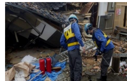
▲ 平成28年熊本地震 応急復旧現場での漏水調査の様子(熊本県益城町)
