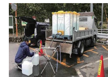
← 仮設水槽からの応急給水
