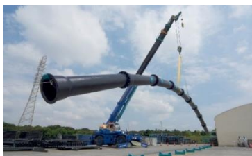
▲ 耐震継手管吊り上げ実験
