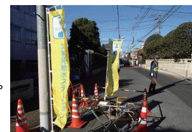
← 消火栓からの応急給水
