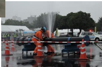
◀水道管応急復旧訓練 模擬的に漏水させた水道管について、破損した箇所 に修理用金具を被せて迅速 に応急修理を行っています。
