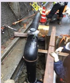
▲仮設導水管布設
