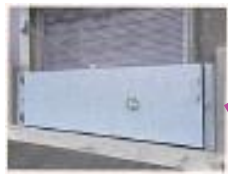
止水堰の設置
