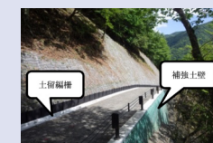
土留編柵、補強土壁
