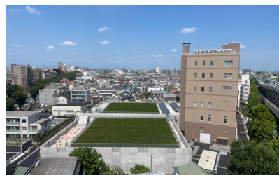
屋上緑化（上北沢給水所）
