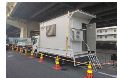
ソーラー電源による移動仮設事務所
