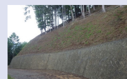
自然侵入促進型植生基材吹付 (施工後)
