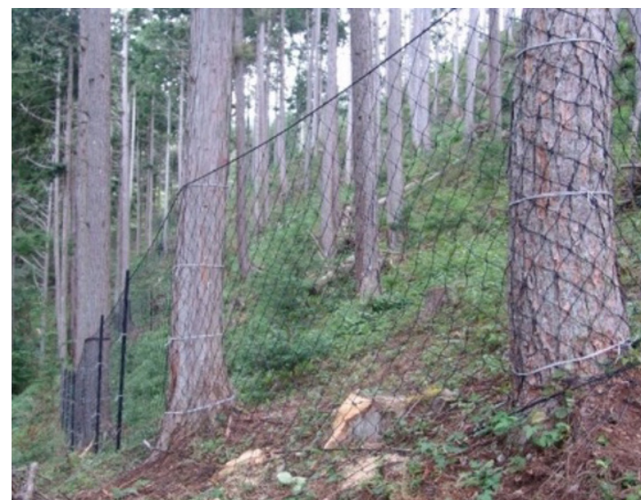
シカ侵入防止柵
