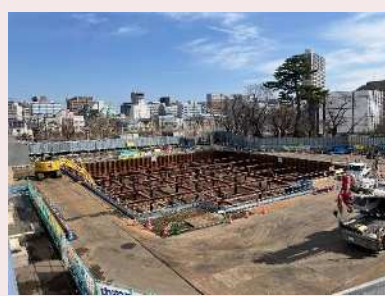
▲柴崎給水所 配水池築造状況
