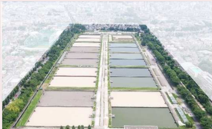
▲工事着手前の境浄水場
