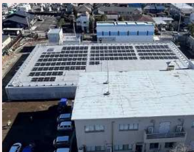
▲深大寺給水所 配水池築造状況
