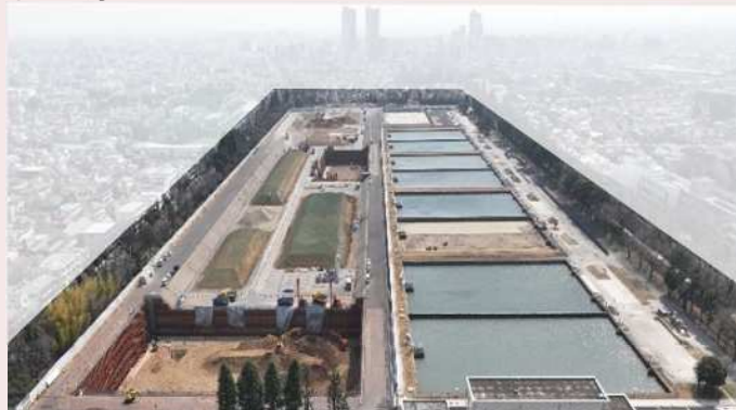
▲工事中の境浄水場 送配水ポンプ所・高度浄水施設の土留及び土工事を実施しています。
