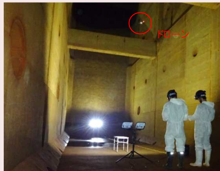
水道局事業への新技術の導入
