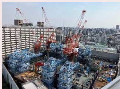
▲王子給水所(仮称) 配水池築造状況
