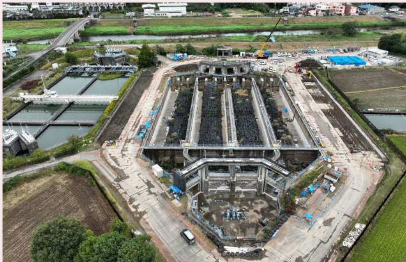
▲朝霞浄水場 沈砂池耐震補強工事を実施しています。
