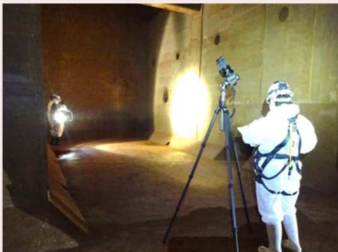
▲ひび割れ等の損傷状況についての調査
