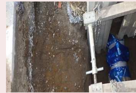
▲給水管撤去後
