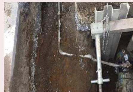
▲給水管撤去前
