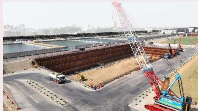
▲工事中の境浄水場 送配水ポンプ所・高度浄水施設の土留及び土工事を実施しています。
