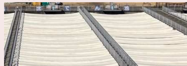
▲シート型による沈殿池の覆蓋化(長沢浄水場) 覆蓋化の工事が完了しました。
