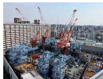
▲王子給水所(仮称) 配水池築造状況
