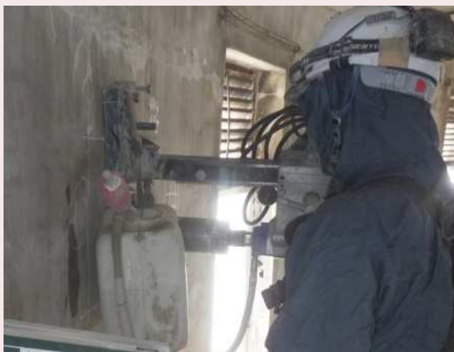
▲コンクリート構造物の供試体の採取
