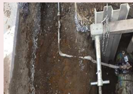
▲給水管撤去前
