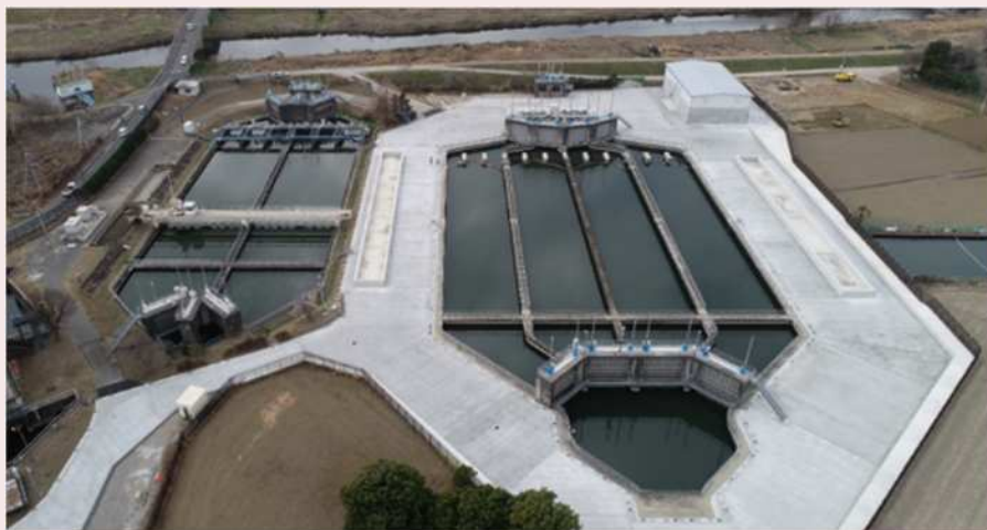
▲朝霞浄水場 沈砂池耐震補強工事が完了しました。
