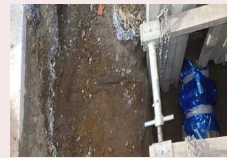
▲給水管撤去後
