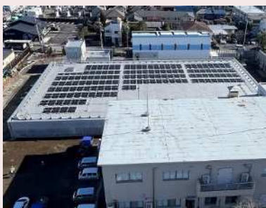
▲深大寺給水所 配水池築造状況
