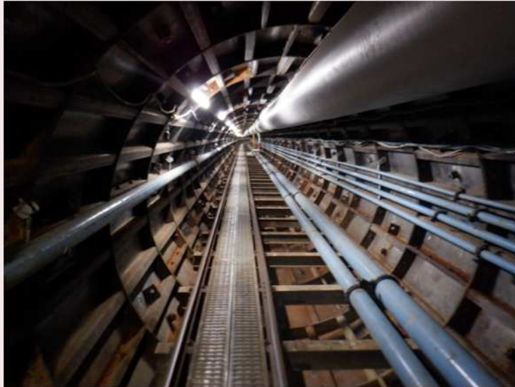
▲シールドトンネルの様子(東村山境線(仮称)) トンネル築造工事を実施しました。
