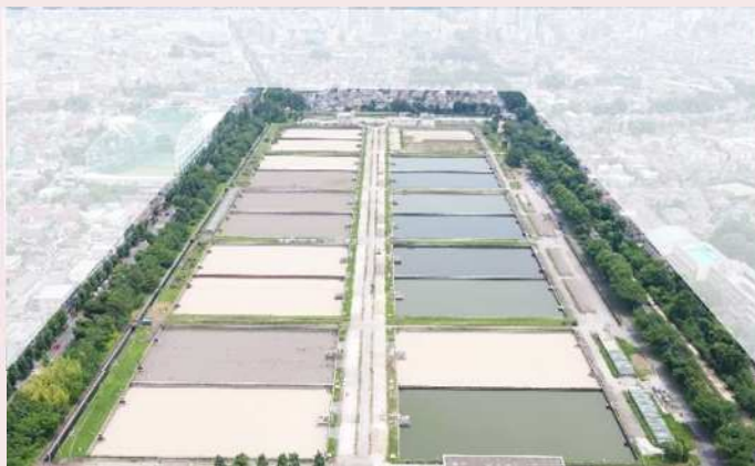
▲工事着手前の境浄水場
