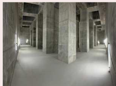
▲王子給水所(仮称) 配水池築造状況
