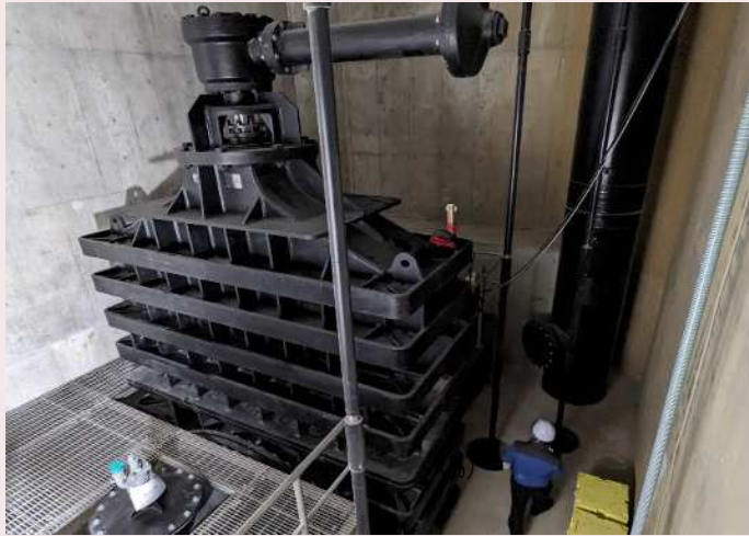
▲制水弁の据付状況 第二朝霞上井草線は、令和5年度に整備が完了し、運用を開始しています。
