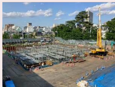
▲柴崎給水所 配水池築造状況
