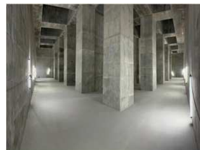
▲王子給水所（仮称） 配水池築造状況
