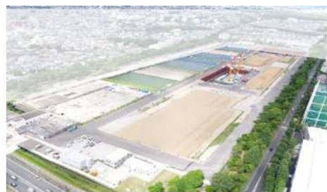
◀ 施工中の境浄水場
