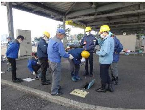
音聴棒を使った漏水調査
