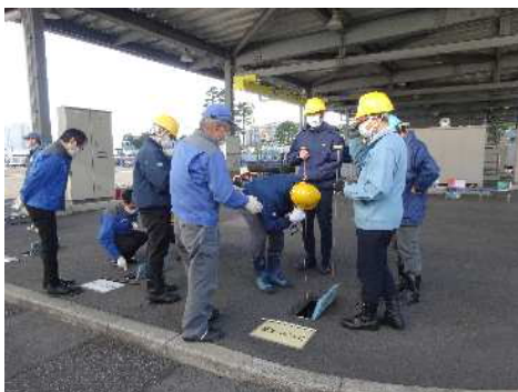
音聴棒を使った漏水調査
