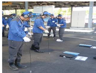
電子式漏水発見器を用いた漏水調査
