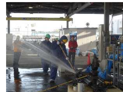
木栓を使った漏水修理
