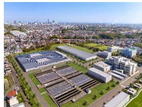
西谷浄水場再整備事業
