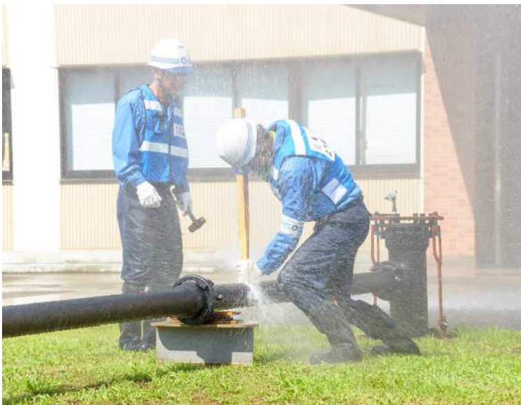
漏水修理デモンストレーション
