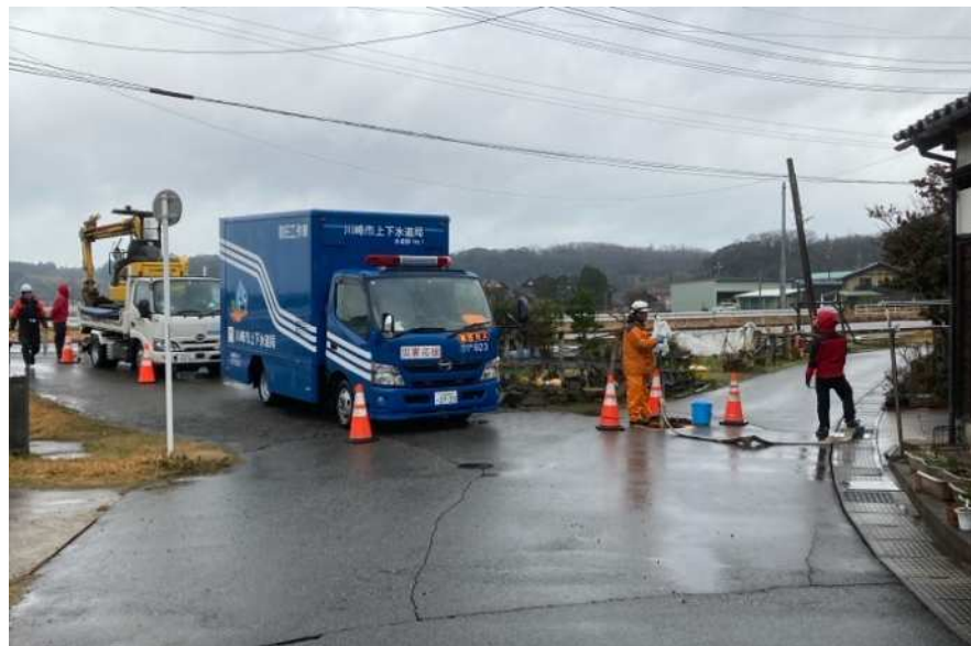
能登半島地震に伴う応急復旧作業
