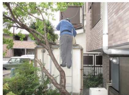
<貯水槽水道の点検調査状況>
