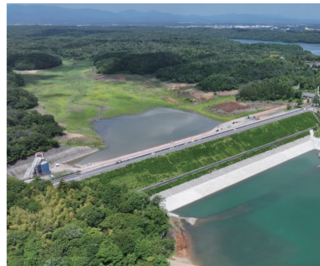
<堤体強化が完了した村山上貯水池>
