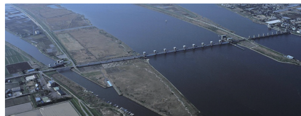
<利根川河口堰>
