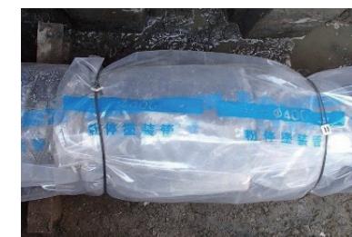
<ポリエチレンスリーブを被覆した管路>
