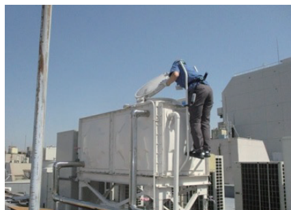
<貯水槽水道の点検調査状況>
