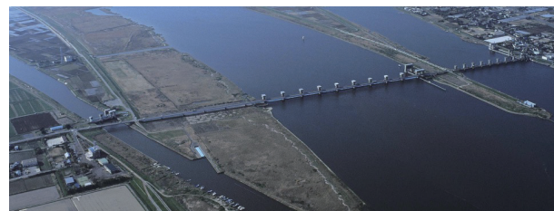
<利根川河口堰>
