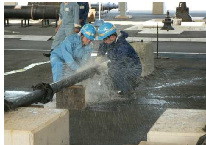
図 18 漏水防止技術研修の様子
