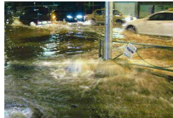
図 1 漏水事故現場
