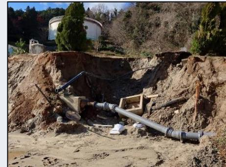
▲浄水場内の配管損傷（七尾市）
