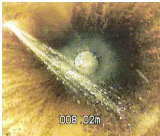
▲老朽化による井戸の破損状況
