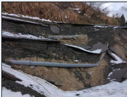
▲送水管の破損・露出（輪島市）
