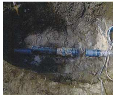
＜漏水した塩化ビニル製の給水管＞
