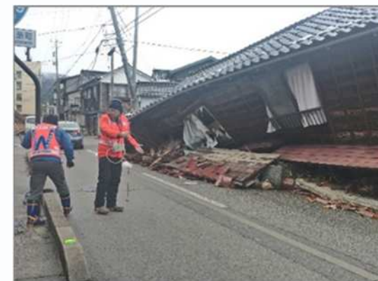
▲ 建物の倒壊状況
