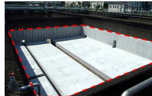
補強後（コンクリート増打ち）
