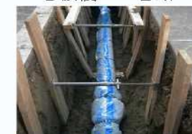
ポリエチレンスリーブを被覆した管路
