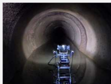
▲内面調査の様子
