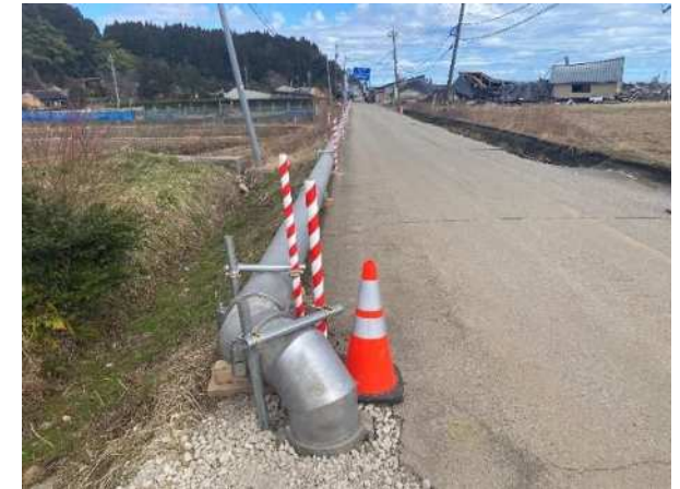
珠洲市 送水管復旧
