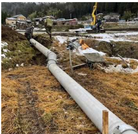
仮設配管の布設例（導水管） （珠洲市宝立浄水場）
