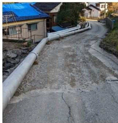
仮設配管の布設例（配水管） （輪島市内）
