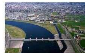
河口堰(筑後大堰:水資源機構)
