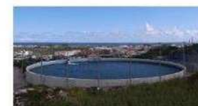
原水調整池 (西原原水調整池:沖縄県企業局)
