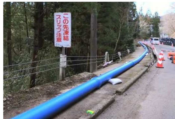
輪島市 配水管復旧
