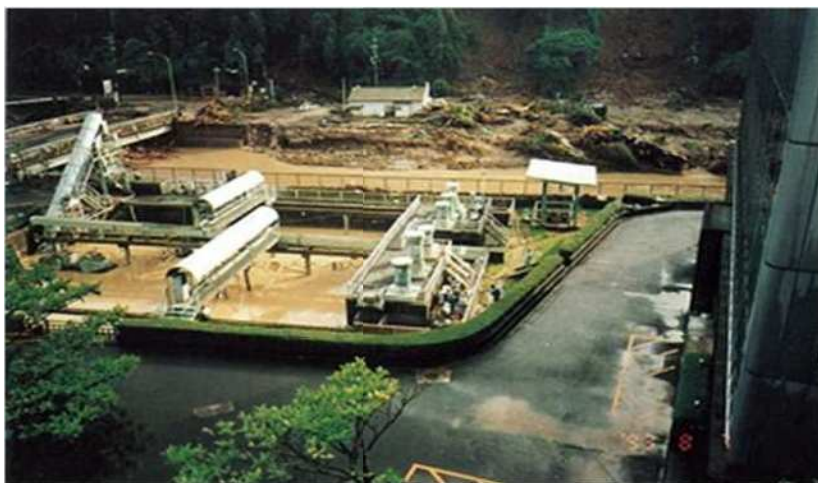
冠水した河頭浄水場
