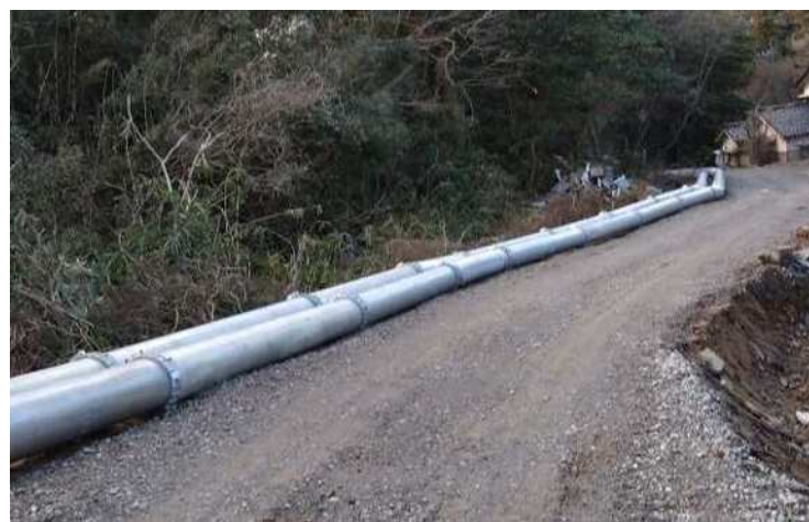
輪島市 送水管復旧
