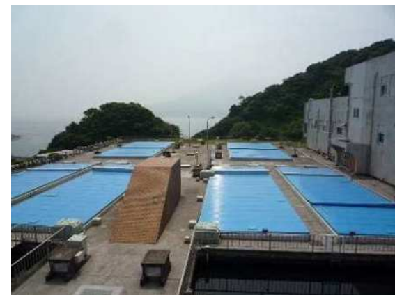
滝之神浄水場 覆蓋
