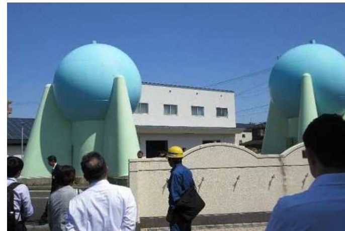
令和6年度現地調査（名古屋市） 比良西応急給水センターの応急給水槽
