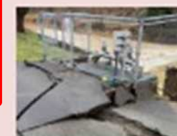
水道の復旧 (被災した浄水場)
