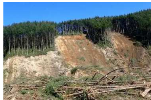
厚真町の斜面崩壊箇所の様子 (北海道開発局提供)
