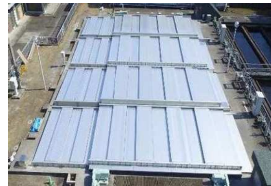
河頭浄水場覆蓋（完成）
