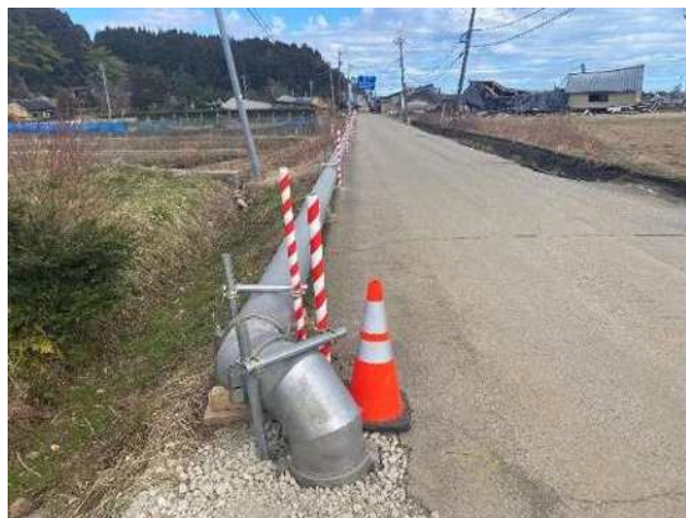
珠洲市 送水管復旧
