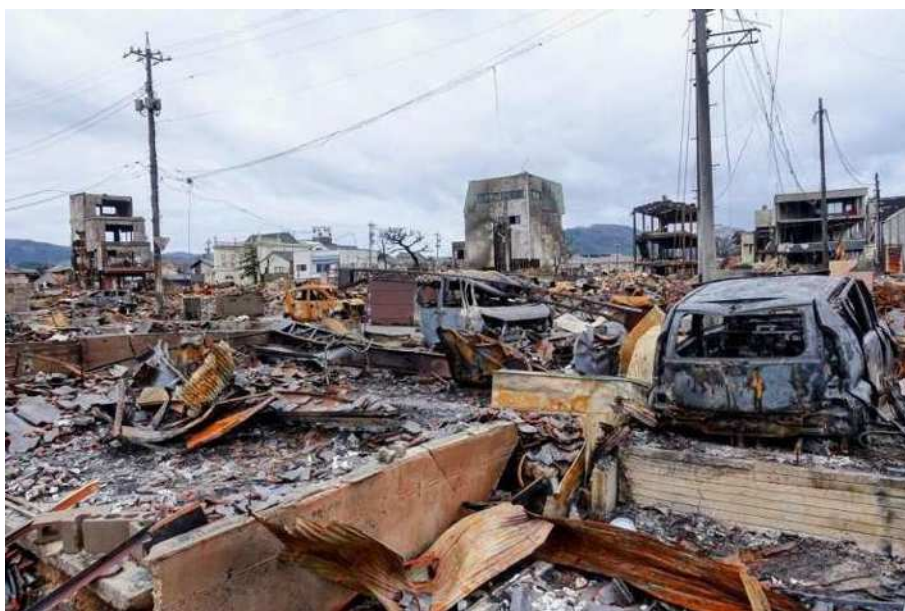
輪島市内の火災被害の様子 (石川県HP 能登半島地震写真で見る被害状況より)
