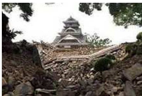
被害を受けた熊本城 (内閣府：平成28年度熊本地震の概要より)
