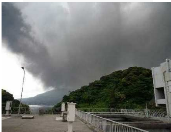
滝之神浄水場 降灰状況
