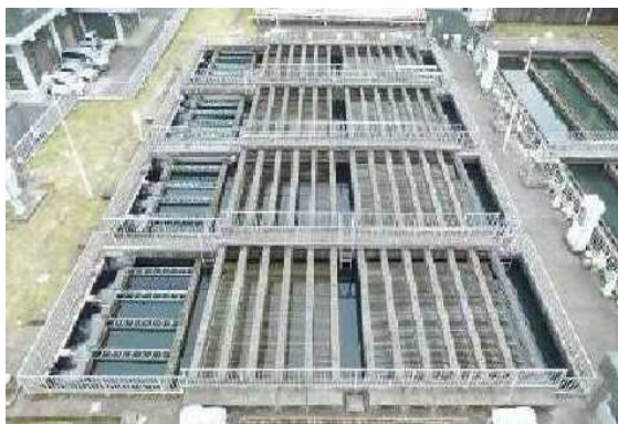
河頭浄水場（着工前）
