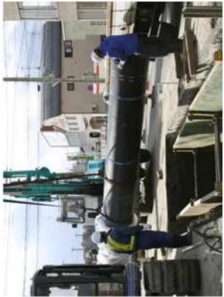
耐震管の布設工事
