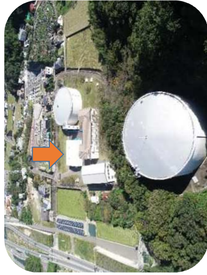
法花谷配水場 テント倉庫
