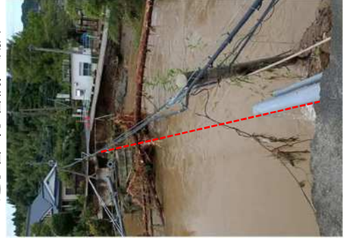
地上配管工事による応急復旧
