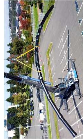
耐震型ダクタイル鉄管採用50周年セミナー (新耐震管GXφ500吊り上げ)
