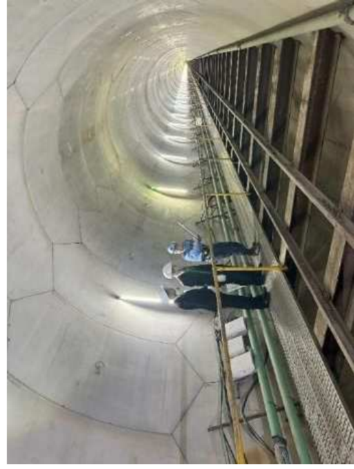
下水道管路の複線化事業 (東京都千代田幹線)
