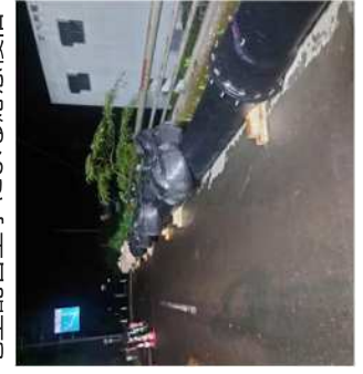
地上配管工事による応急復旧
