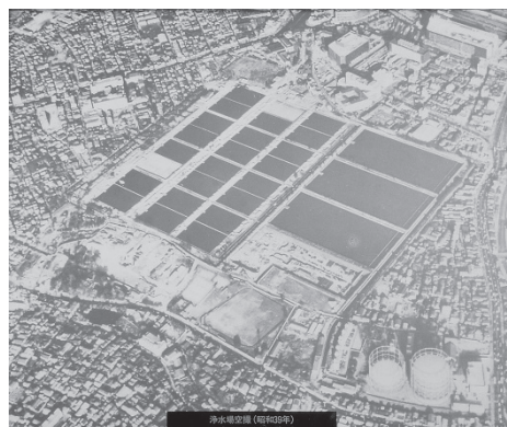
淀橋浄水場（昭和39年頃）
