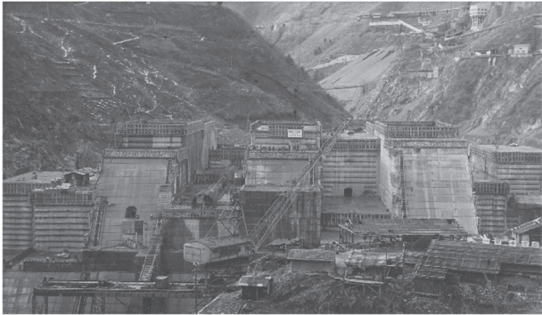
小河内ダムの建設風景
