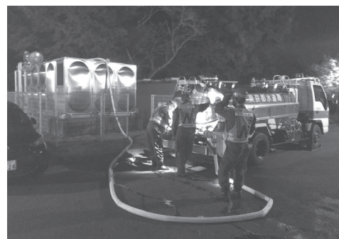
福祉施設の受水槽へ給水（静岡市）
