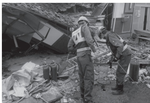
漏水調査（熊本県益城町）
