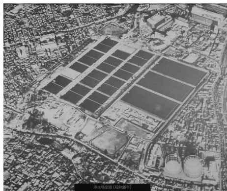
淀橋浄水場（昭和39年頃）
