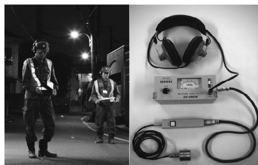
電子式漏水発見器を用いた漏水調査 （地下漏水防止対策）
