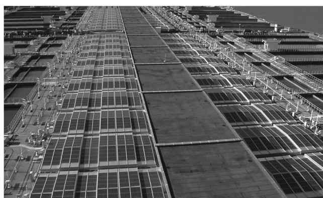
太陽光発電（朝霞浄水場）
