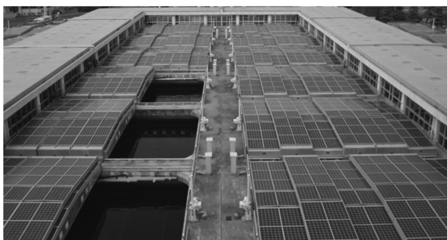
急速ろ過池（上部は覆蓋及び太陽光発電設備）
