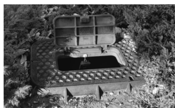
一体型スマートメータ 鉄製のメータボックス
