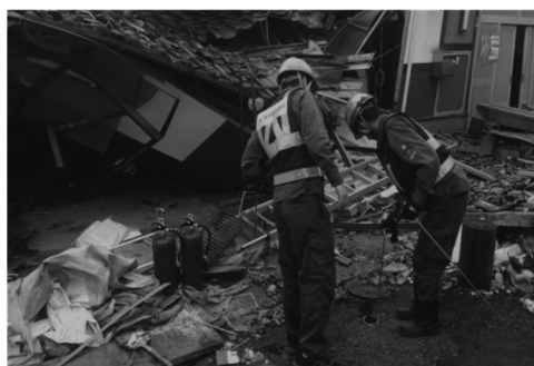
漏水調査（熊本県益城町）
