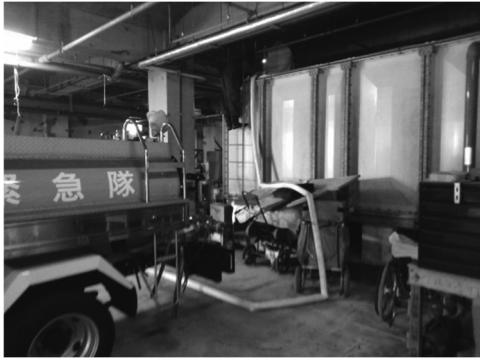
福祉施設の受水槽へ給水作業（新島村）
