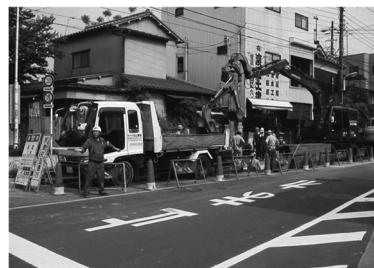
緊急漏水修理工事（地上漏水防止対策）
