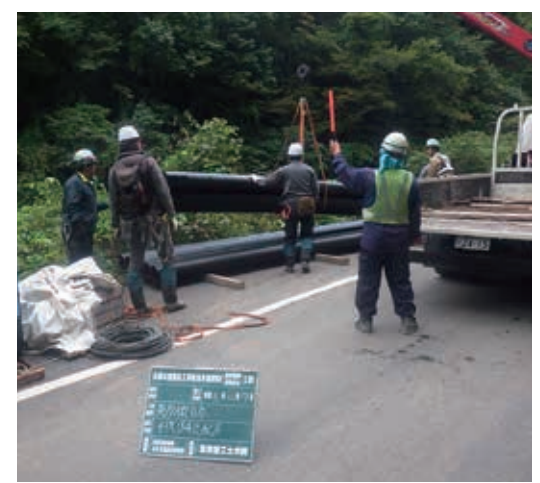
▲ 水道管の工事
