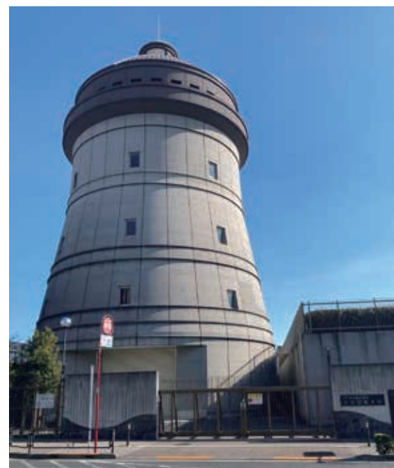
▲ 大谷口給水所（板橋区）
