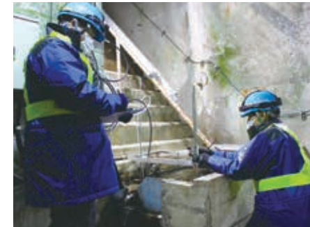
▲ ダムにいつもとちがうところがないか、かくにん確認しているところ
