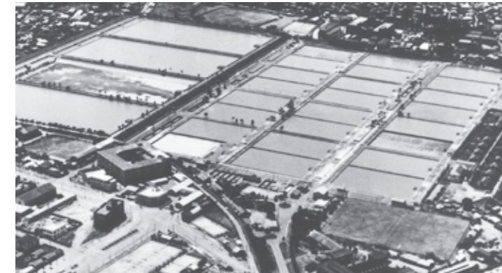
▲ 新宿にあった淀橋浄水場
