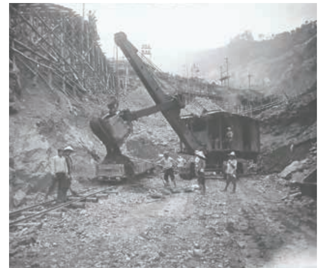
▲ 小河内ダムの建設現場（昭和17年）
