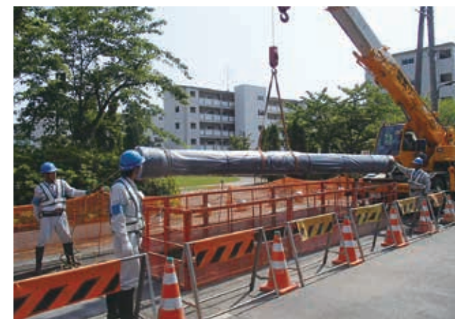
▲ 道路下の水道管工事の様子（1本の水道管の長さは約5m）
