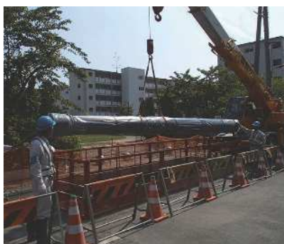
水道管路の取替工事の様子
