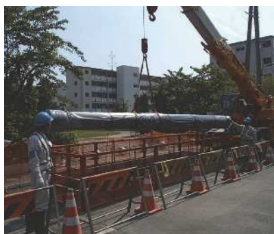
水道管路の取替工事の様子
