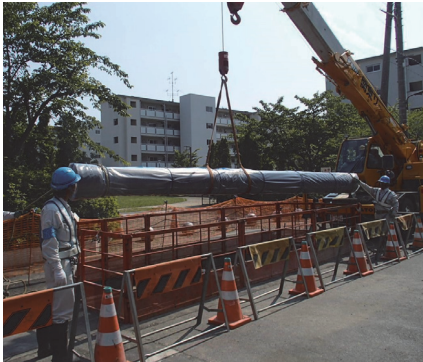
水道管路の取替工事の様子
