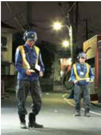
夜間の漏水発見作業
