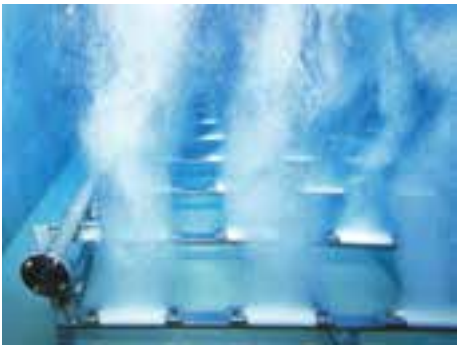
オゾン接触池
