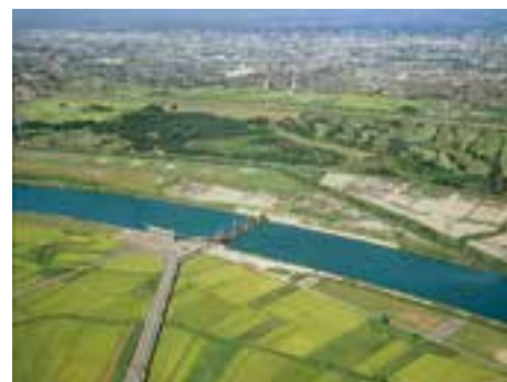
秋ヶ瀬取水堰（出典：水資源機構）
