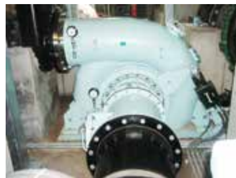
給水所における小水力発電設備
