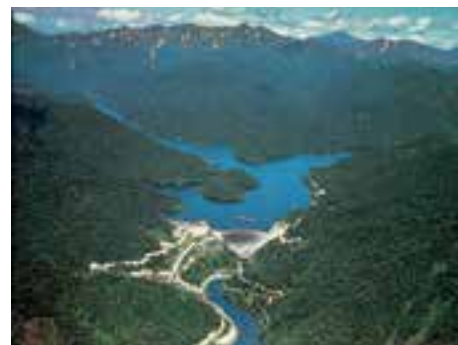
矢木沢ダム（出典：水資源機構）
