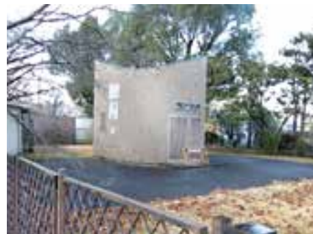
日比谷公園の応急給水槽
