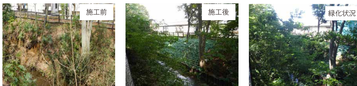
＜連続繊維補強土工による法面保護工実績：井の頭橋上流（左岸）＞
