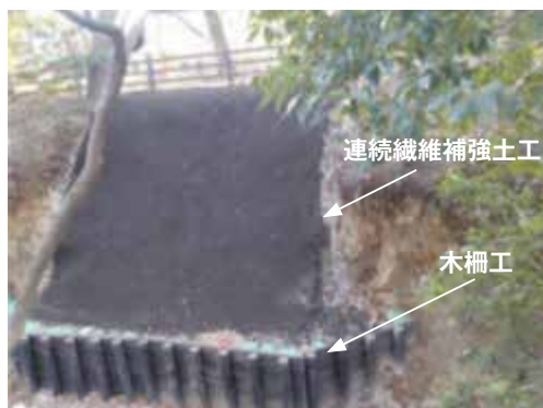
写真-10 法面保護工施行例
