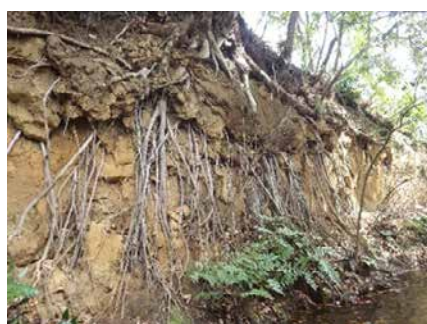
＜根系発達による表層の崩落＞
