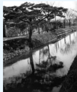
<昭和16年 三鷹橋下流> 東京都水道歴史館所蔵
