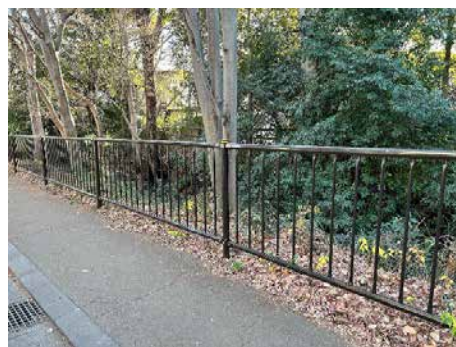
＜道路（歩道）沿いのフェンス＞ （幸橋下流）
