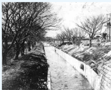
<昭和8年頃 境浄水場付近> 出典「境浄水場拡築工事概要」、東京都水道局、昭和8年3月
