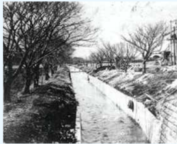
＜昭和8年頃 境浄水場付近＞ 出典「境浄水場拡張工事概要」、東京都水道局、昭和8年3月
